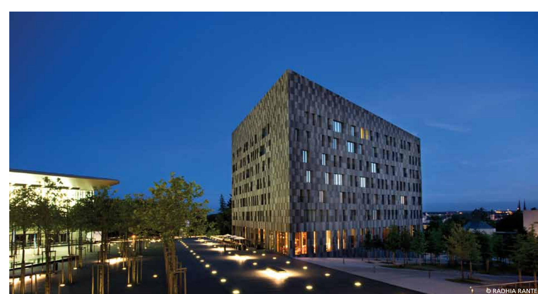
HÔTEL MELIA ARCHITECTE: JIM CLÉMENT ATELIER D'ARCHITECTURE ET DE DESIGN INGÉNIEURS-CONSEILS: INCA INGÉNIEURS-CONSEILS 2009
