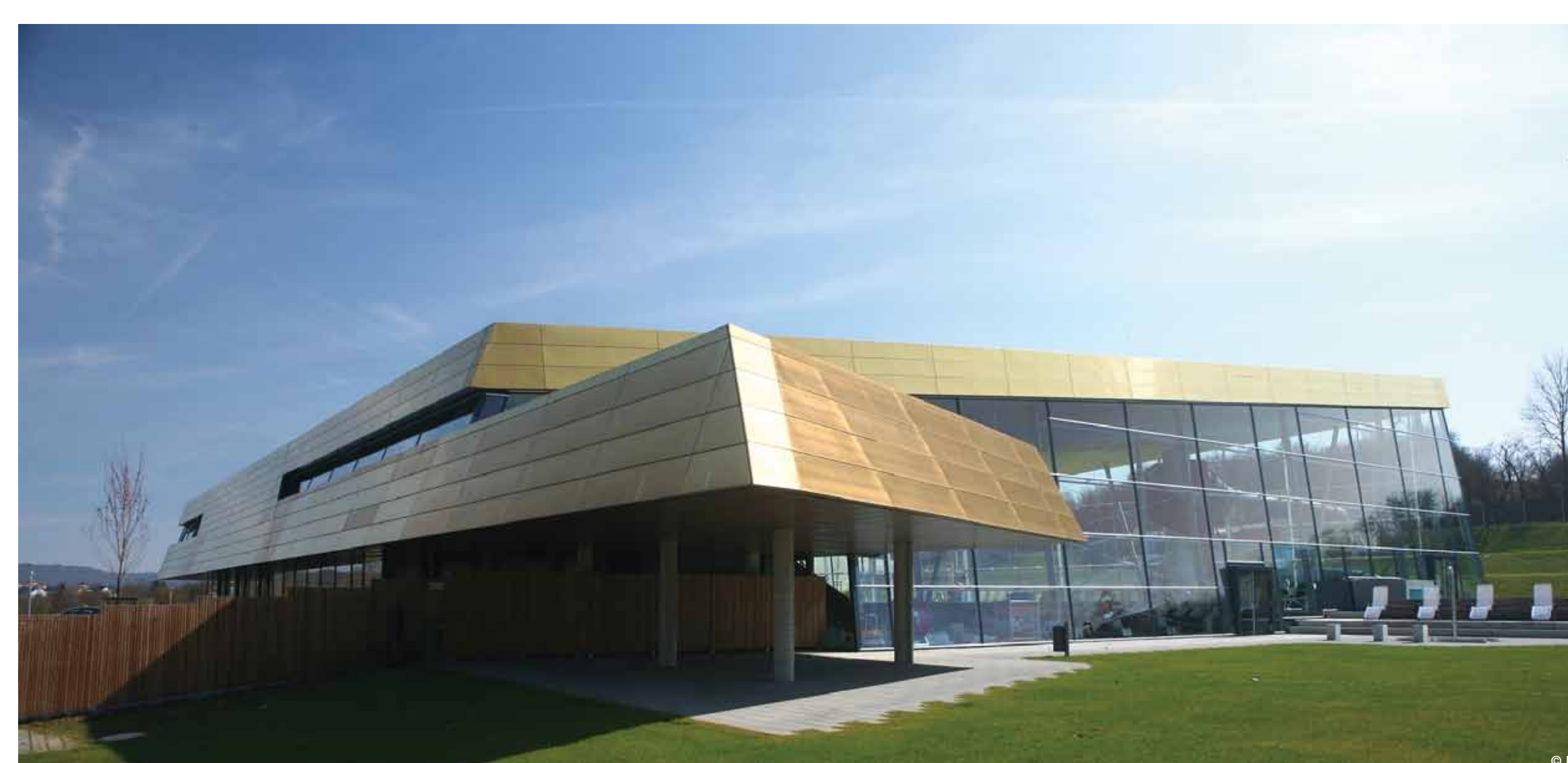
NIEDERANVEN - PISCINE ARCHITECTES: AA-ARCHITEXTEN GMBH 2010
