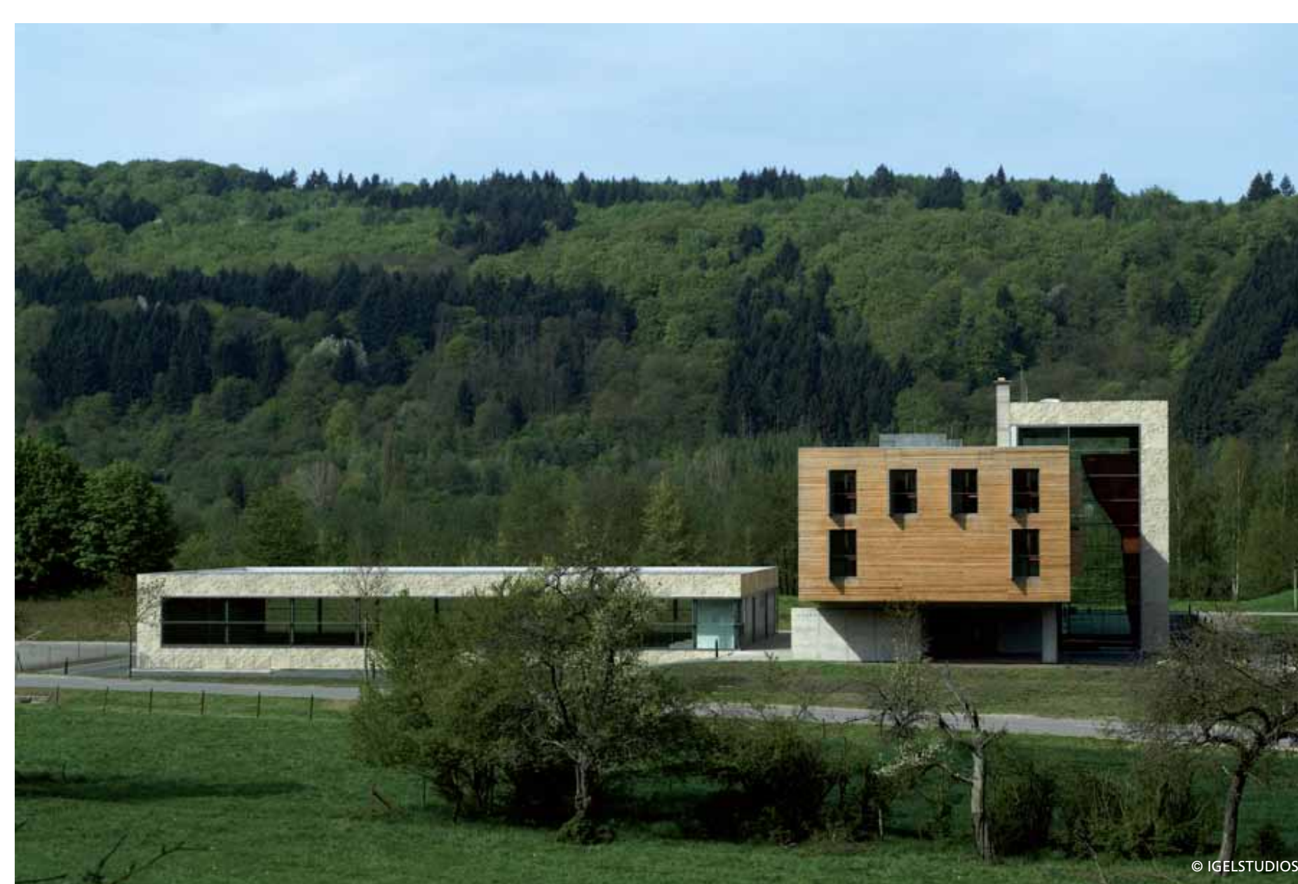
ECHTERNACH - AUBERGE DE JEUNESSE ARCHITECTES: WITRY & WITRY ARCHITECTURE URBANISME INGÉNIEURS-CONSEILS: SGI INGENIERIE, GOBLET LAVANDIER & ASSOCIÉS 2005
