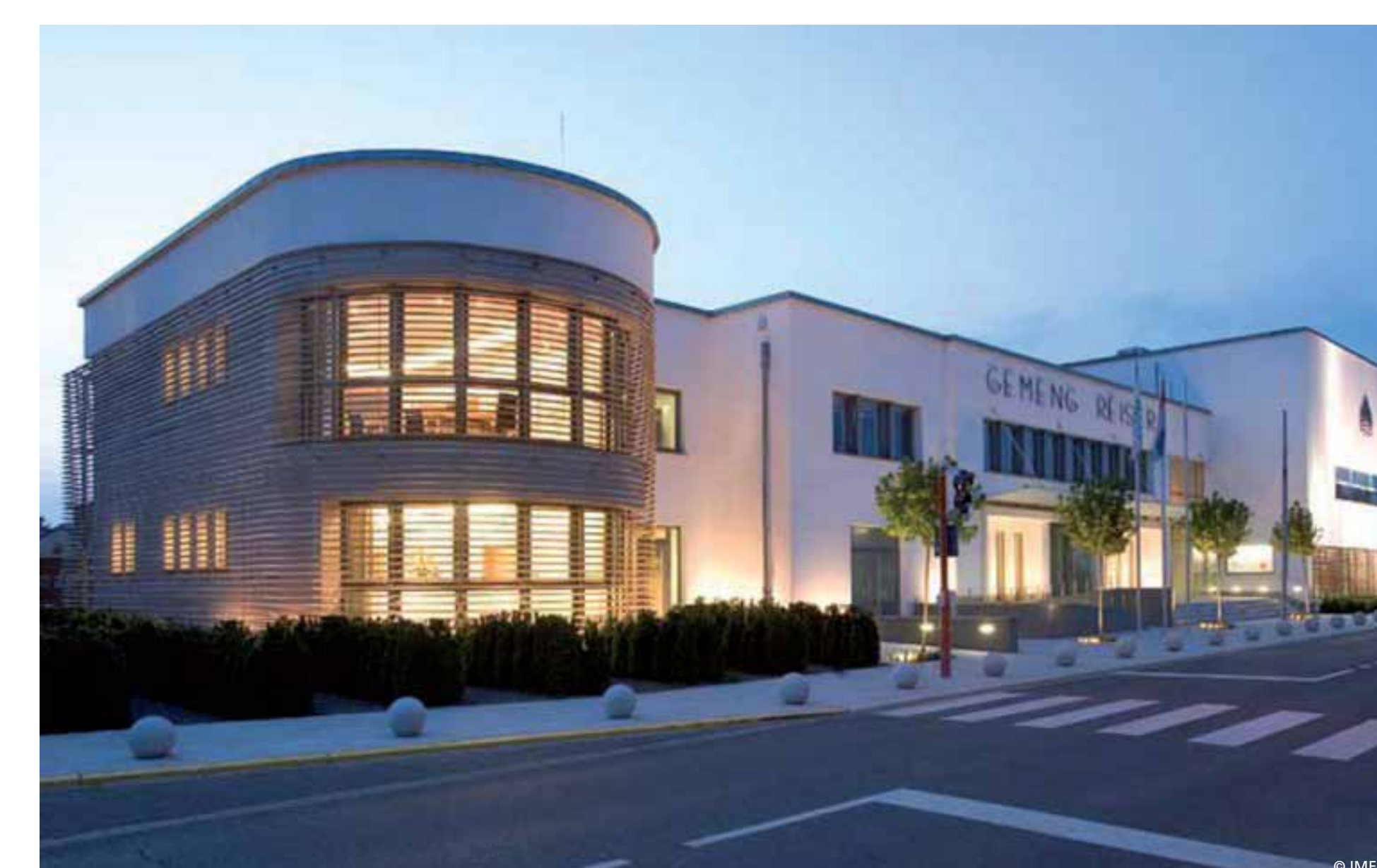
ROESER - MAIRIE ARCHITECTES: SCHMEL & WITTY INGÉNIEURS-CONSEILS: SMTECH SA, GOBLET LAVANDIER & ASSOCIÉS 2004
