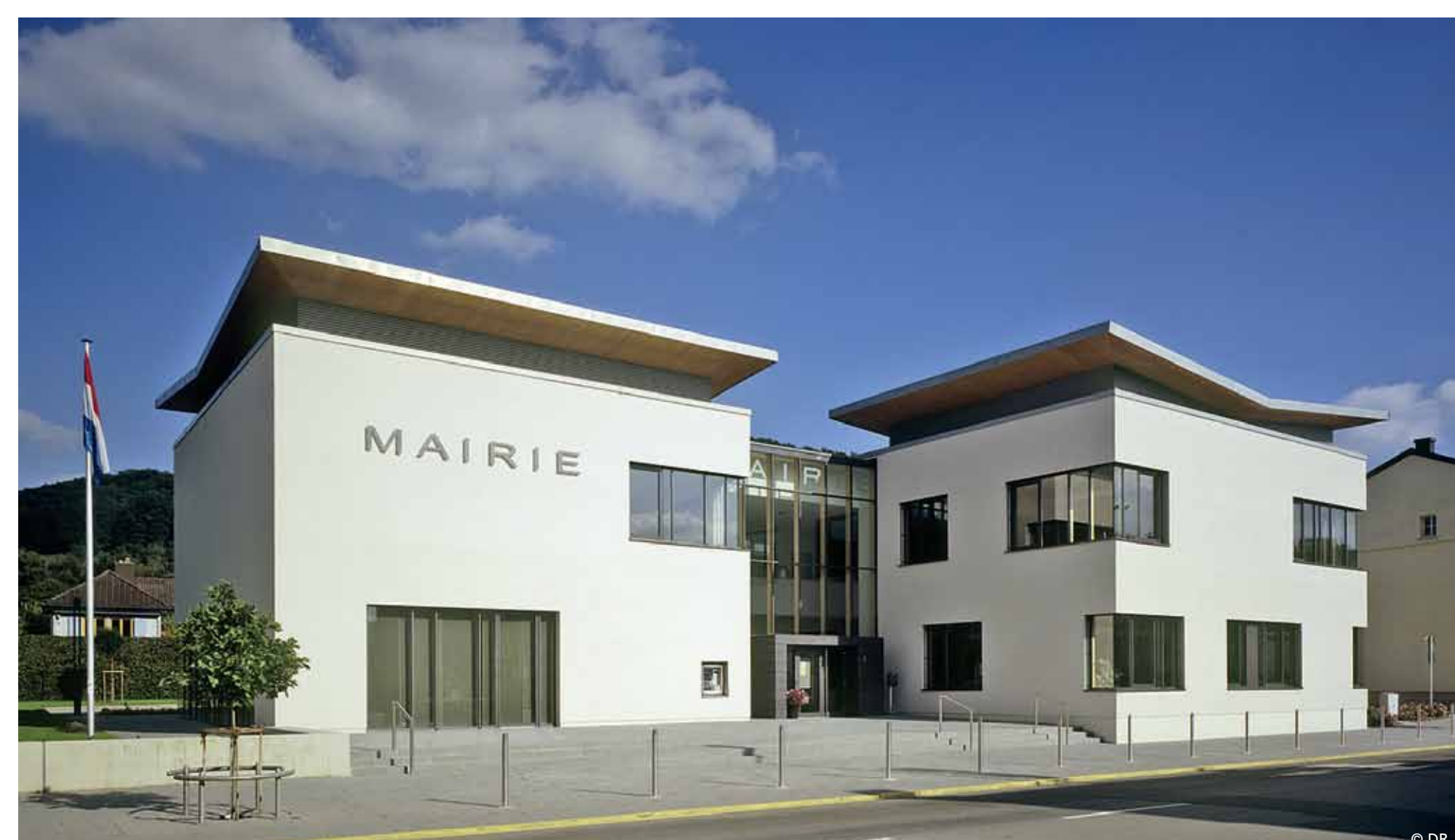
LORENTZWEILER - NOUVELLE MAIRIE ARCHITECTES: HOWECCO BRUNN ARCHITECTES / REICHER HAASE ARCHITEXTEN INGÉNIEURS-CONSEILS: SCHROEDER & ASSOCIÉS 2006
