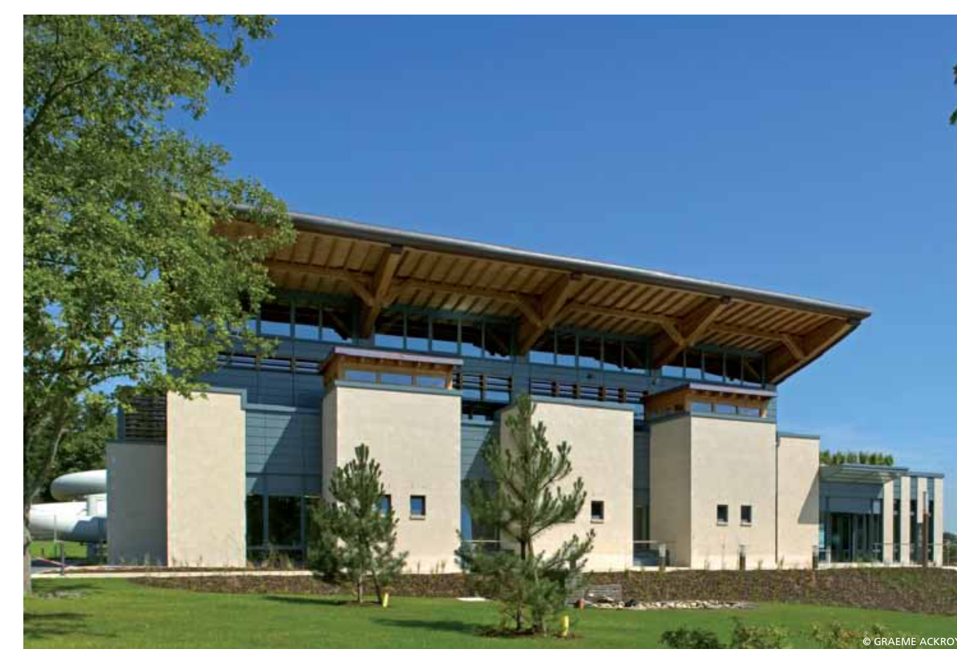
MERSCH - CENTRE AQUATIQUE KROUNBERG ARCHITECTES: DECKER LAMMAR & ASSOCIÉS INGÉNIEURS-CONSEILS: SCHROEDER & ASSOCIÉS, TELGEN & ASSOCIÉS 2007
