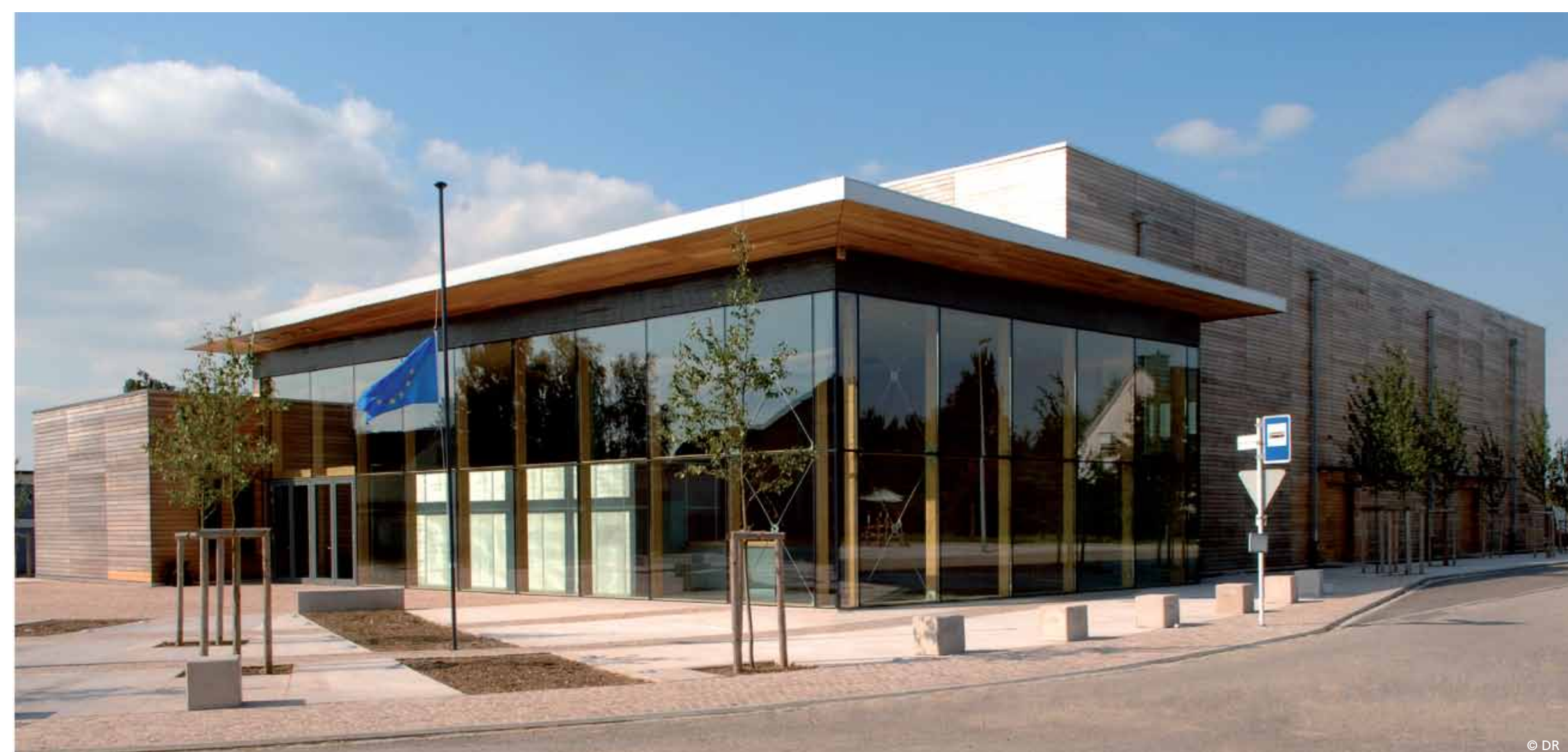
MARRACH - CUBE 521 ARCHITECTES: ROMAN HOFFMANN ARCHITECTES & URBANISTES INGÉNIEURS-CONSEILS: SGI INGENIERIE, GOBLET LAVANDIER & ASSOCIÉS 2007
