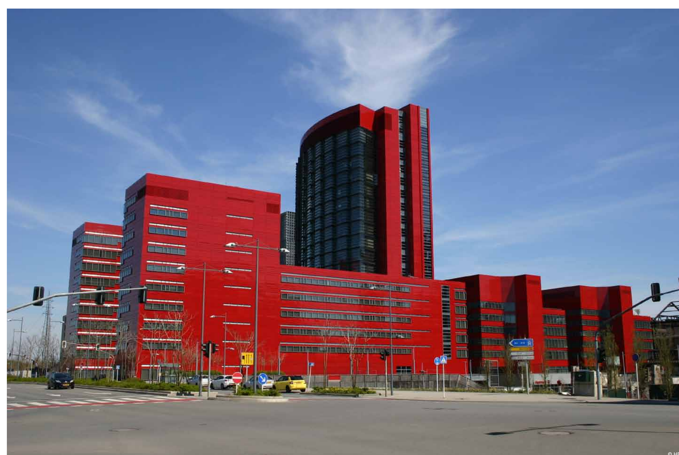
BNL, BEUVA ARCHITECTE: CLAUDE VASCONI ASSOCIÉS ET JEAN PETIT, 2005 BEZUG ZUM STANDORT DURCH DIE METALLVERLEBUNG. FARBIG ALS AUCH "POPPIE" "MOODERN" "WINDENWAND" SAGTE "COLA-DOME". RÉFÉRENCE AU SITE INDUSTRIEL. REVEITEMENT EN METAL, COULEUR POP.
