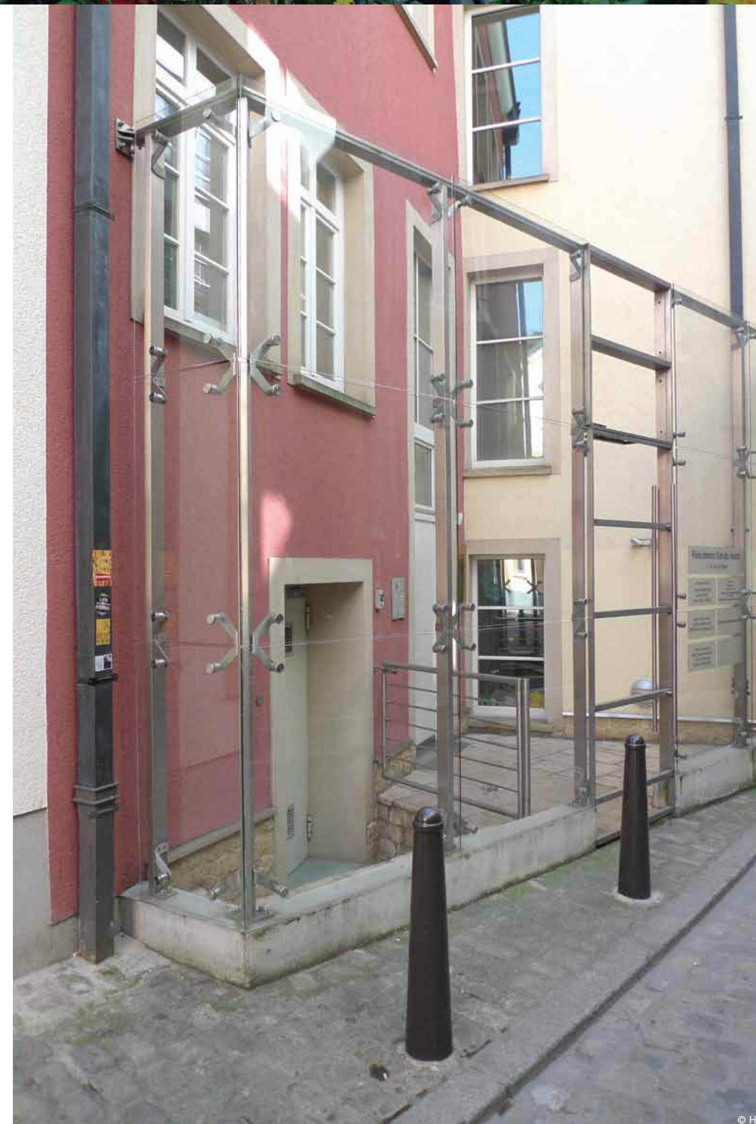
RUE DU NORD IN DER ALTSTADT PER VERGLASUNG NOTHILFEN-SCHUTZTSCHE. COIN PITTORISQUE DOTÉ DE MESURES ANTI-PPR.
