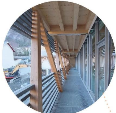
Coursive extérieure étage demi-pension
