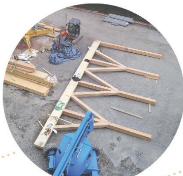
Assemblage poteaux nouvelle coursive
