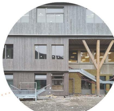
Façade nouvelle coursive : structure épiciée, bardage douglas irisé
