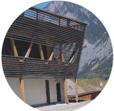
Enveloppe : bardage ajouré sur structure
