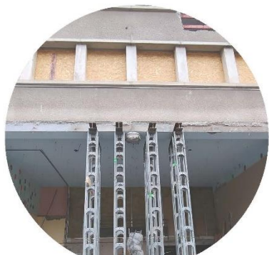
Façade barre existante
