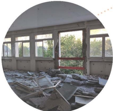
Barre existante : démolition de quelques allèges de fenêtres
