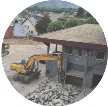
Démolition des extensions des années 1980
