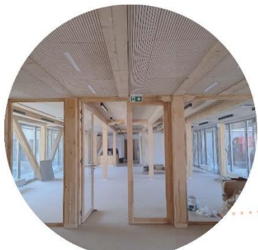
Détail de plafond CDI : passage des gaines entre les poutres
