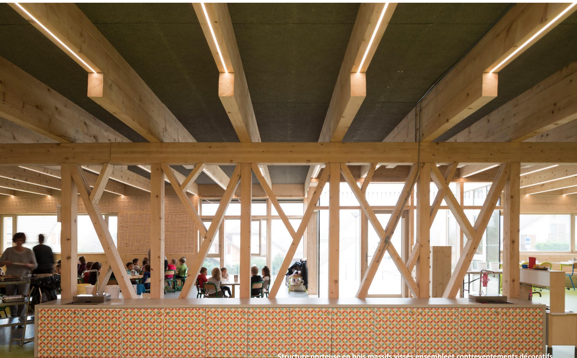
Structure porteuse en bois massifs vissés ensembleet contreventements décoratifs
